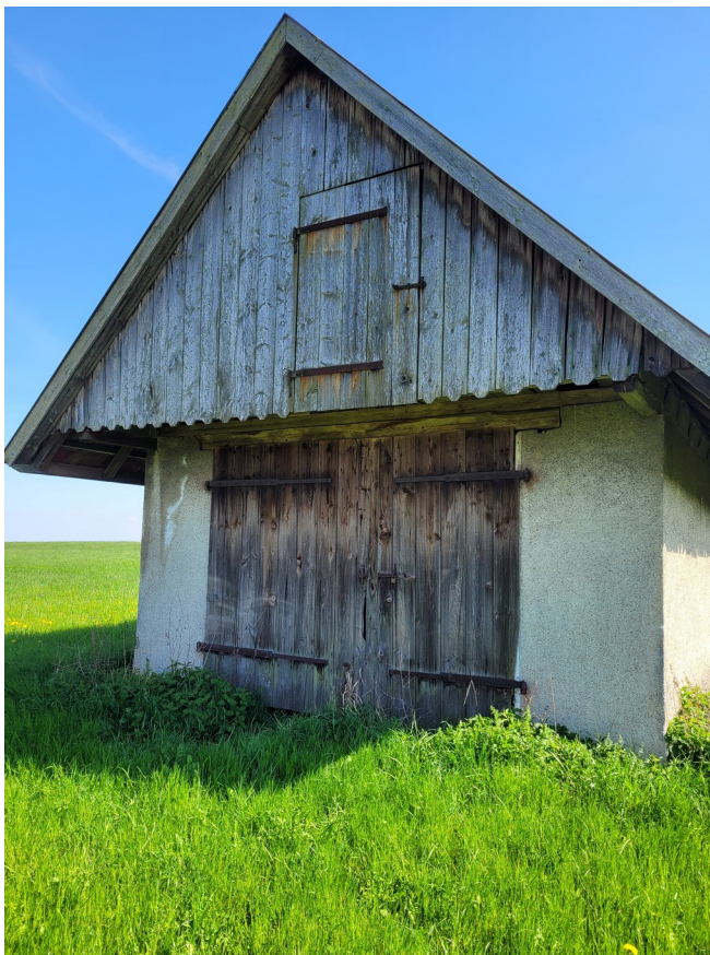
Feldscheune westlich des Plangebietes (potentielle Fortpflanzungstätten für bebäudebewohnende Vögel und Fledermäuse)
